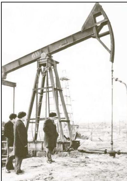
Рис. 5. Скважина, оборудованная ШГН с полой безмуфтовой штангой (труба \text{Ø}43 \times 3,5 мм). Подвеска насоса на глубине 700 м
