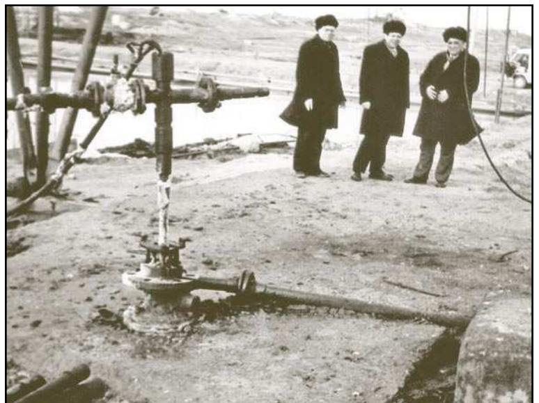
Рис. 4. Скважина оборудованная ЭЦН с непрерывной насосно-компрессорной колонной. Подвеска насоса на глубине 720 м Fig.4. A well completed with electric rotary pump with continuous tubing. The pump setting depth is 720 meters
