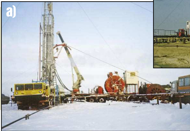
Рис. 2. Схема расстановки оборудования при проведении работ по отрезанию прихваченных НКТ: а) скважина № 8318, б) скважина № 1276
