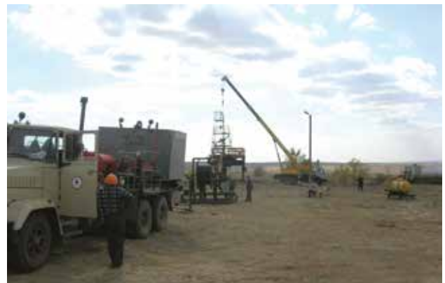
Рисунок 1 – Первый опыт работы с полимерной армированной трубой
