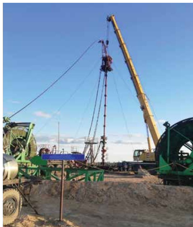
Рисунок 5 – Спуск пакер-пробки и перфорационной системы на скважине 411g
