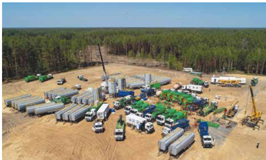
Рисунок 7 – Расстановка оборудования на скважине 155g Figure 7 – Equipment placement on well 155g
