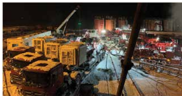
Рисунок 2 – Расстановка флота ГРП на кустовой площадке
