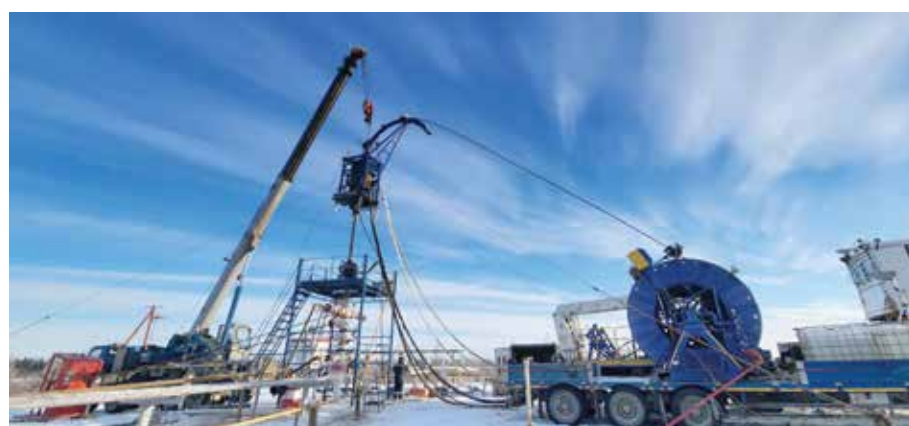
Рисунок 2 – Процесс проведения работ по креплению ПЗП
