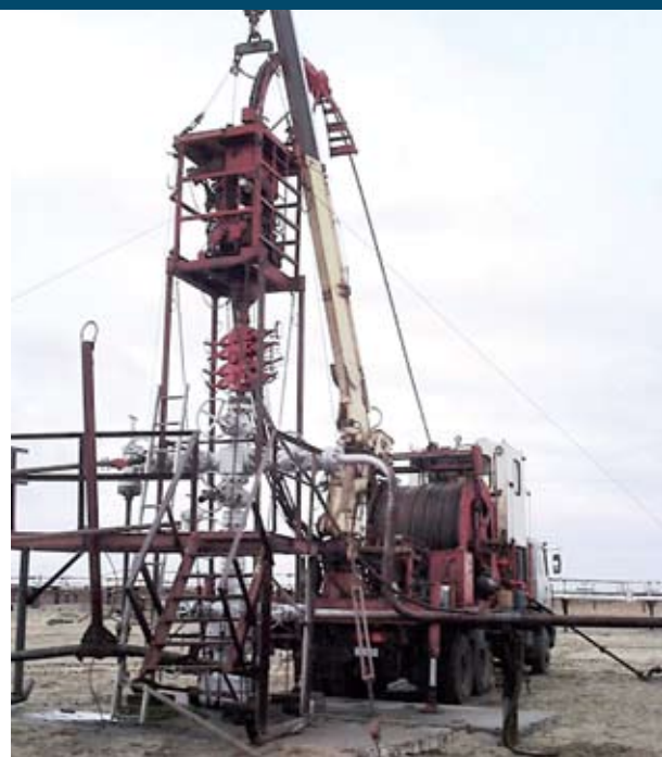
Рисунок 1 – Глушение скважины с помощью колтюбинговой установки
