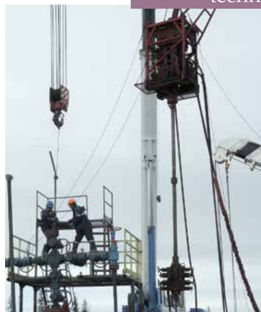
Рисунок 4 – Извлечение 12 шт. геофизических грузов Figure 4 – Retrieving of 12 geophysical weight assemblies
