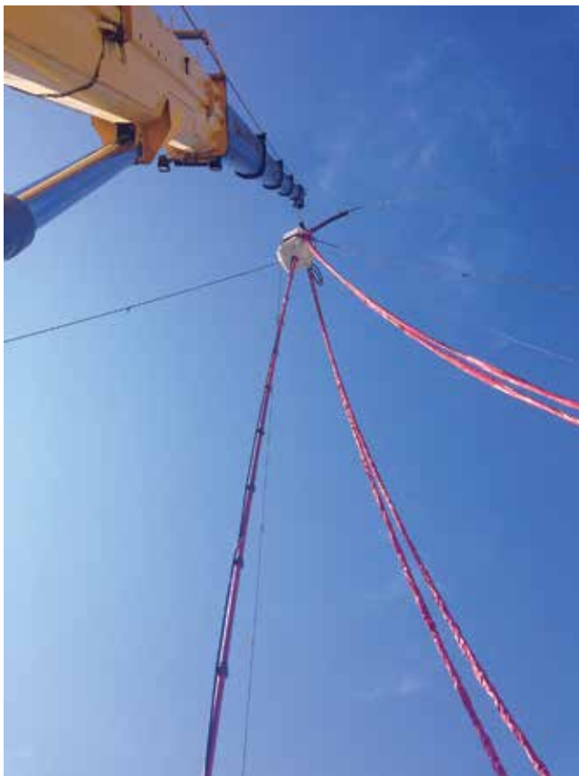
Рисунок 3 – Лубрикаторная колонна длиной более 26 м при проведении ГИС
