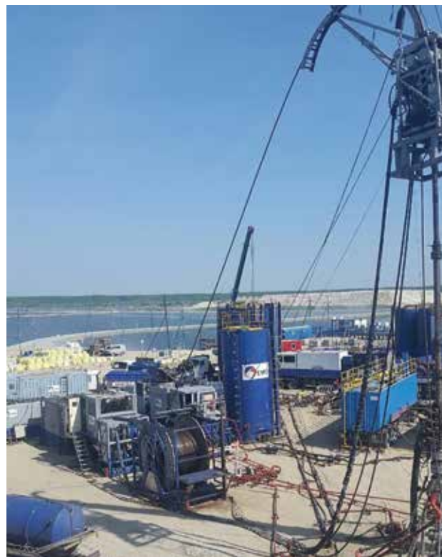
Рисунок 2 – Монтаж комплекса ГНКТ Figure 1 – CT Fleet rig-up
