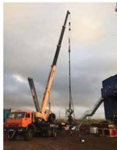
Монтаж устьевого оборудования
