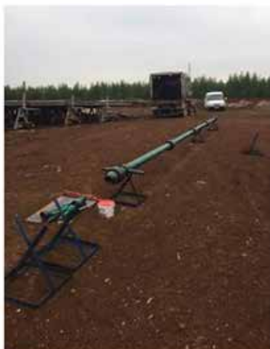
Сборка секций лубрикатора
