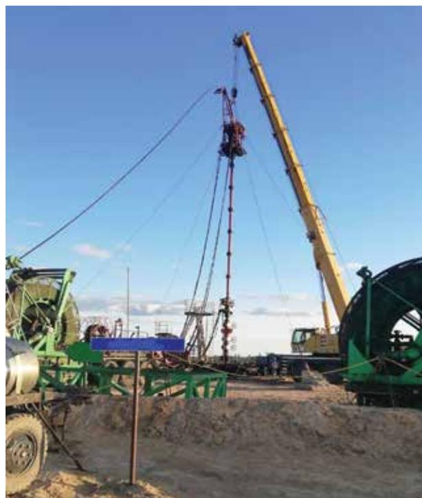
**Рисунок 5 – Спуск пакер-пробки и перфосистем на скважине 411g**
