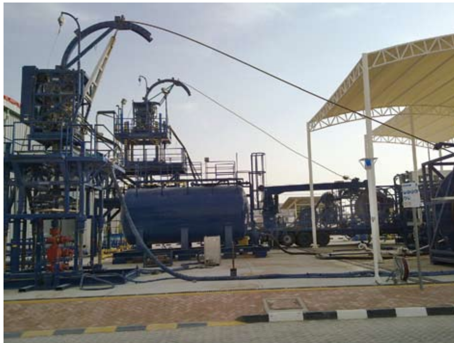
Рисунок 2 – Кустовая площадка для двух установок ГНКТ – HydraRig и X-11 Figure 2 – Coiled Tubing pad with 2 CT units – HydraRig and X-11
