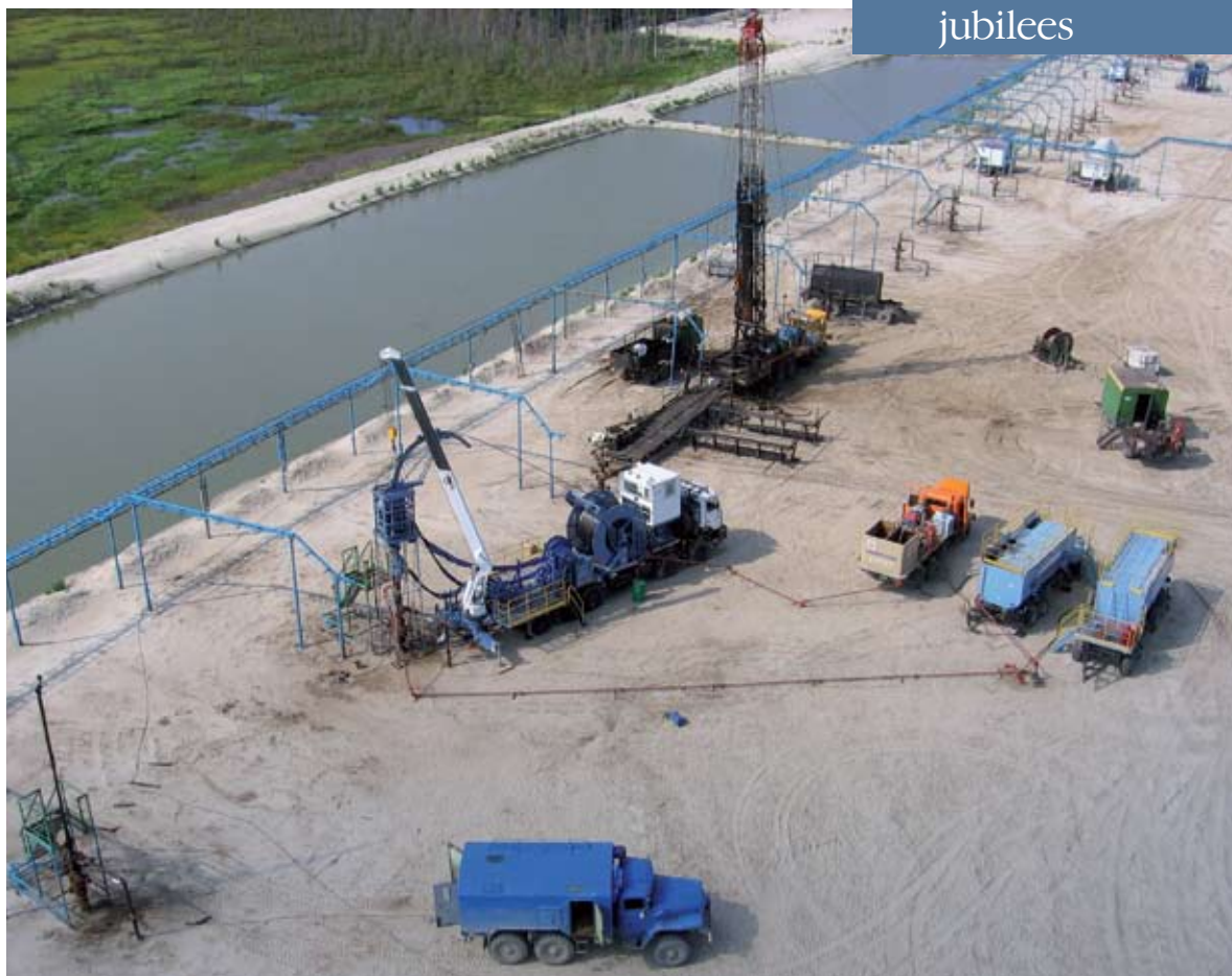
Пусконаладка колтюбинговой установки. Бургаз, 2007 At the CT unit commissioning and start-up. Burgaz, 2007
