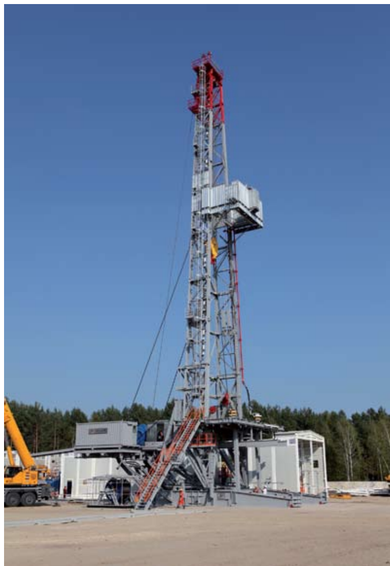
Буровая установка Drillmec. Речицкое месторождение Drillmec drilling unit. Rechitsa Field
