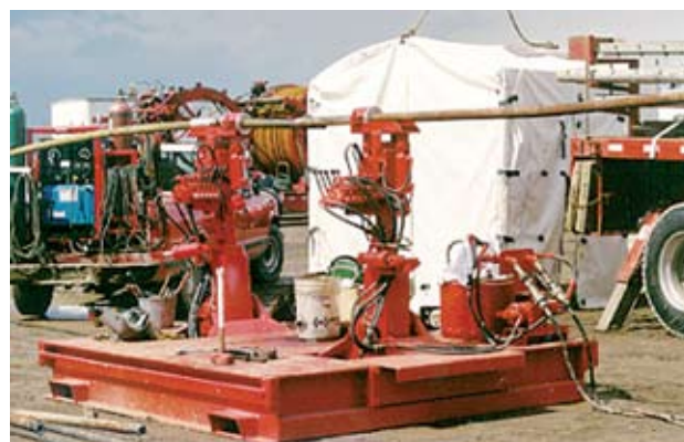
Рисунок 1 – Сварочный станок и палатка для аргонно-дуговой сварки ГТ «встык» Figure 1 – Welding Jig and Habitat for TIG Welding of CT Butt Joints
