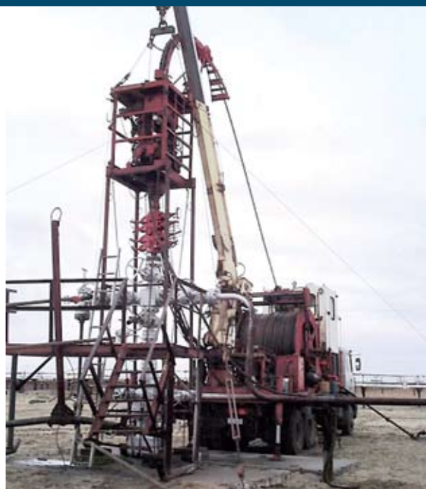
Рисунок 1 – Глушение скважины с помощью колтюбинговой установки
