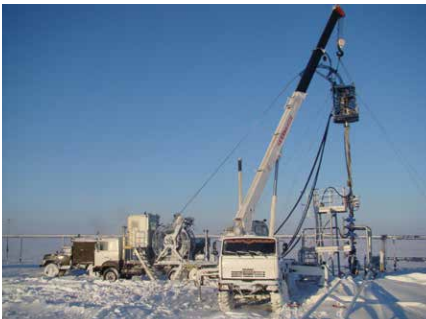
Флот ГИС на ГНКТ во время записи скважинных параметров. Песцовое НКГМ ООО «ГАЗПРОМ ДОБЫЧА УРЕНГОЙ» Coiled tubing well logging equipment during the process of borehole data acquisition. Pestsovoe oil-gas condensate field of GAZPROM DOBYCHA URENGOY, LLC
