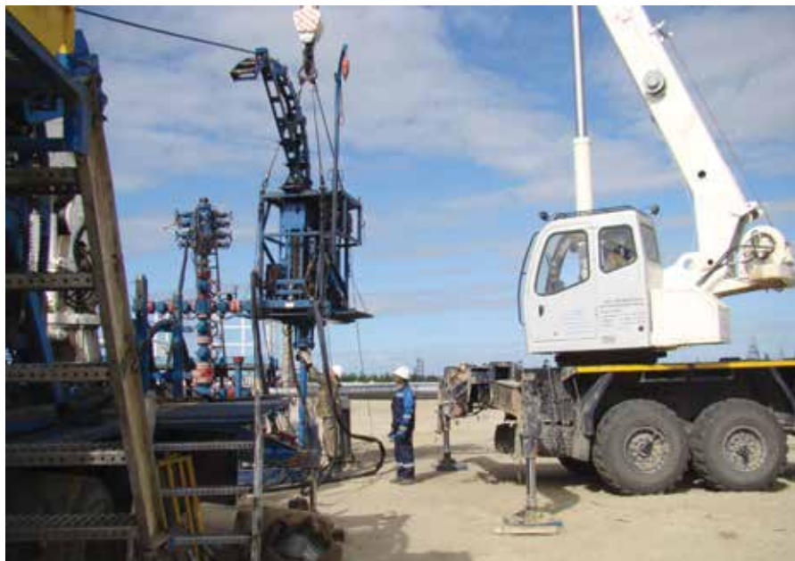
Момент монтажа лубрикатора перед проведением ГИС на скважинах ЗНГКМ ООО «ГАЗПРОМ ДОБЫЧА ЯМБУРГ»
