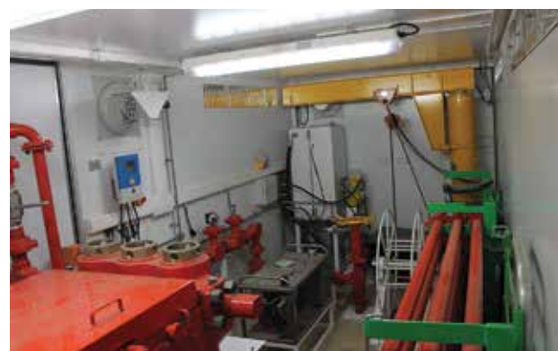
Рисунок 4 – Установка УНН2. Система дозирования ацетата хрома и ручная таль
