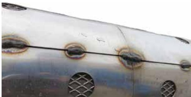
**Рисунок 1 – Защитный кожух с применением сварки, состоящий из листов металла длиной 1 метр**
