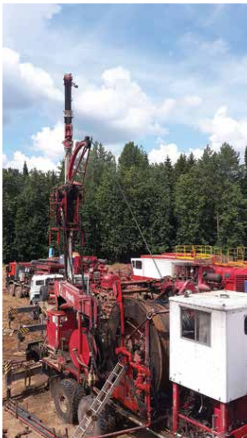
Рисунок 3 – Смонтированное оборудование ГНКТ ООО «Пакер Сервис»
