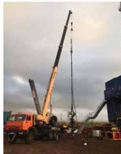
Цикл подготовительных работ включает в себя шаблонировку ствола скважины незаряженной компоновкой с проходным локатором муфт и имитатором пакер-пробки. По завершении монтажа шаблона в камеру лубрикатора производится опрессовка устьевого давления на 50 МПа. Во время шаблонировки скважины осуществляется привязка по реперным патрубкам, что в дальнейшем позволяет проводить установку пакер-пробки и проведение перфорации с точностью до 0,5 м.
